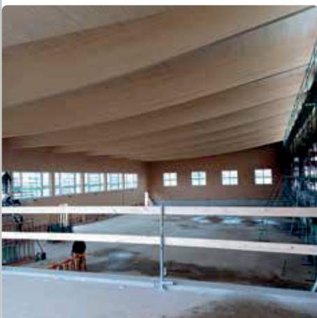
Bereits kurze Zeit später wurden die Bodenplatte, die tragenden Außen- und Innenwände sowie Stahlbeton-Decken von der Baufirma Otto Reischl GmbH betoniert. Diese Betonarbeiten bildeten die Grundlage für den anschließenden Holzbau. Die Zimmerei Dirr arbeitete intensiv daran, das Dach der neuen Ballsporthalle bis Dezember 2025 zu errichten. Der Abschluss der Rohbauarbeiten erfolgte mit der Aufstellung eines Richtbaumes durch die Zimmerer.
